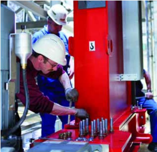
Das neue Regalbediengerät ist 12 t schwer und hat eine Masthöhe von knapp 23 m. (Foto: AL-KO)
