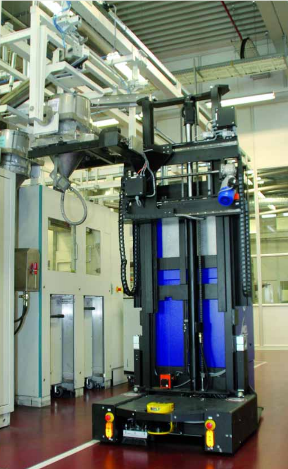
Alles unter Kontrolle: Ein komplexes Leitsystem übernimmt die Steuerung der Fahrzeuge.
